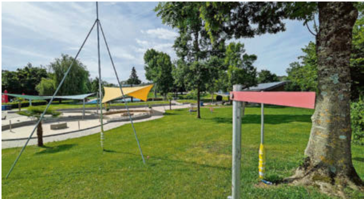
Bauvisiere zeigen an, wo der Hallenbadneubau hinkommt. Foto: tba
